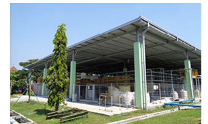
廃水処理施設
