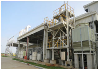
廃水処理施設
