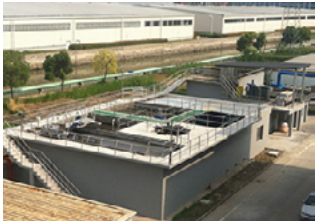
廃水処理施設
