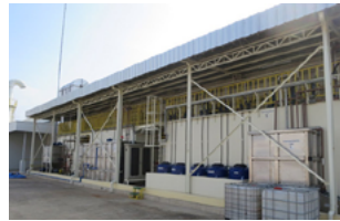
廃水処理施設
