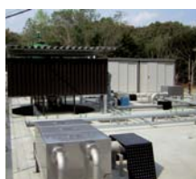
更新した浄化槽
