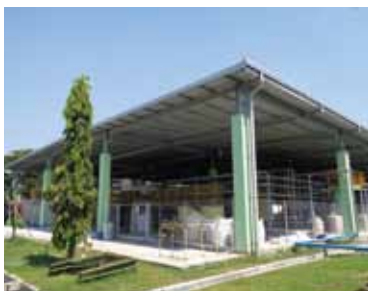
インドネシアの廃水処理施設
