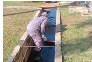
構内の水路の清掃
