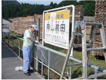
阿仁前田駅での塗装作業の様子
