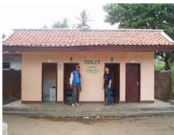
3カ所目となる共同水場の建設
