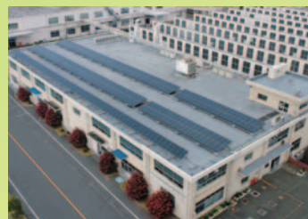
太陽光発電システム (ヤマハ(株)本社工場)
